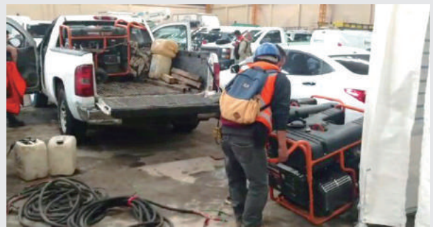
紧急协调油机保障站点通信
