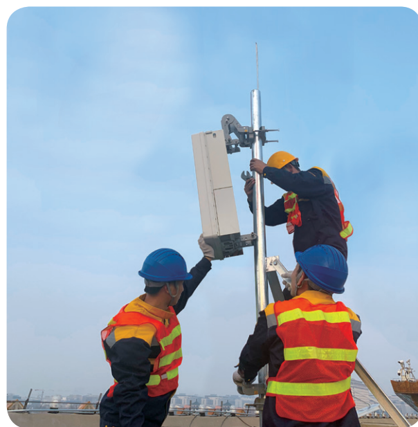
华为5G 64T64R AAU部署安装，华为5G全场景站点助力全球5G大规模快速部署。
