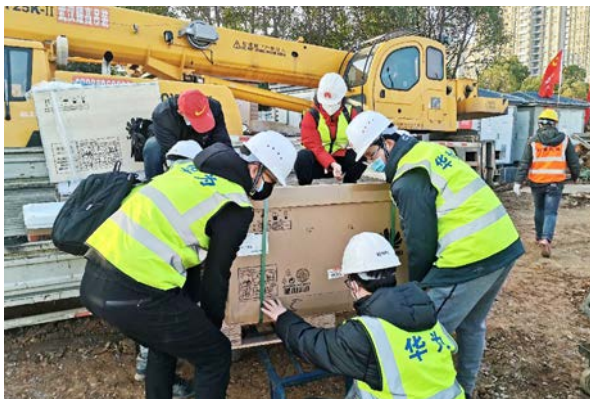
华为网络设备搬运现场
