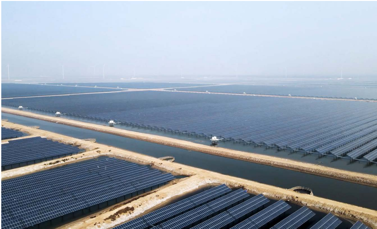
中国山东滨州沾化“渔光一体”项目
