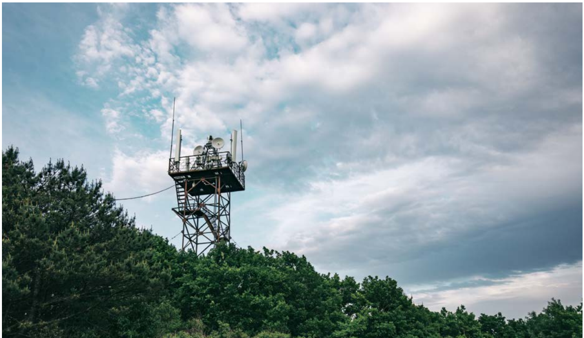
东北虎豹国家公园 LTE 基站，利用原有的防火塔，减少对自然的影响
