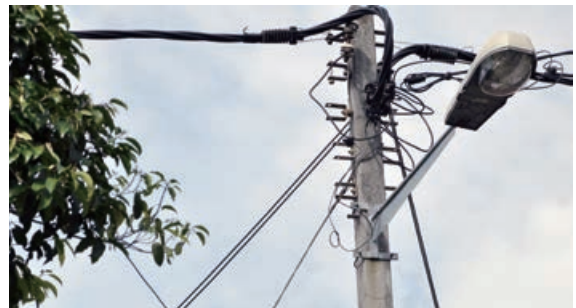
马来西亚D-CCAP设备挂缆安装
