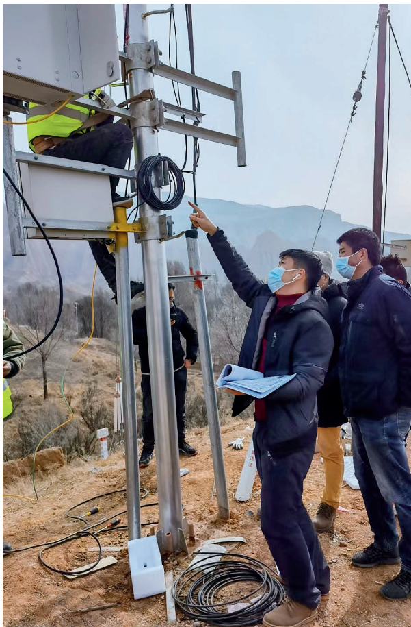
产品线专家现场教施工队安装 AirPON 设备
