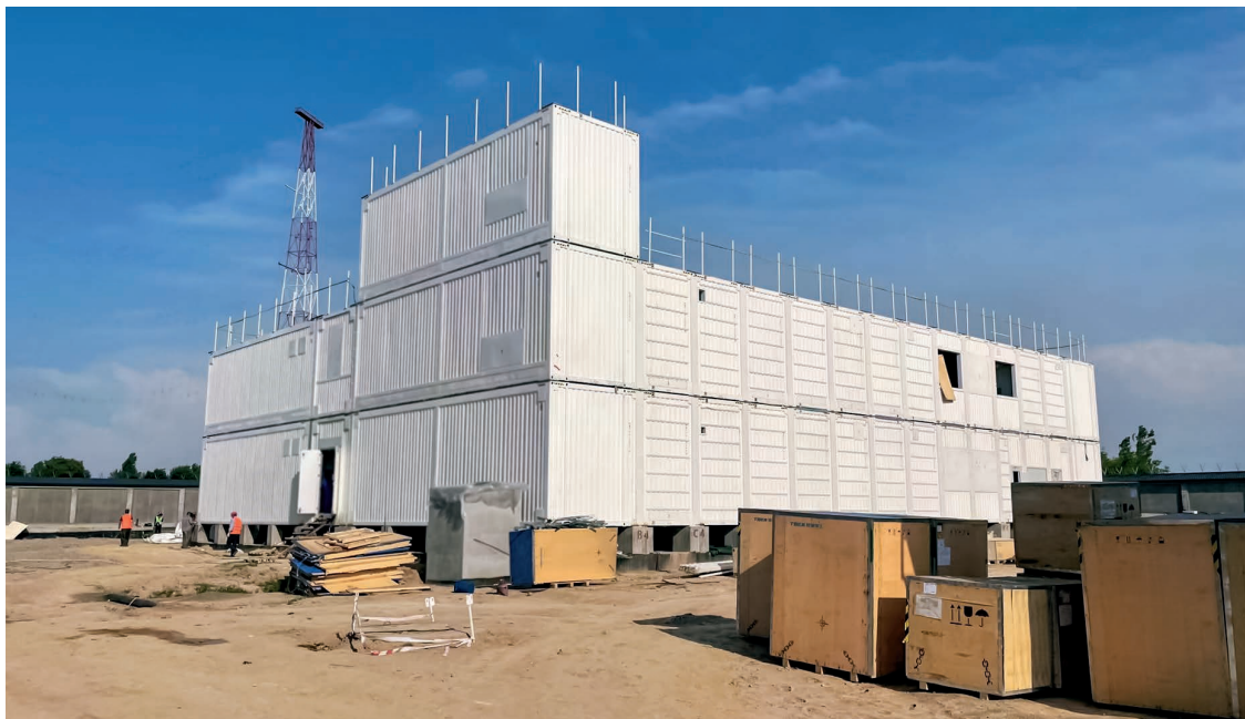
数据中心建设工地现场
